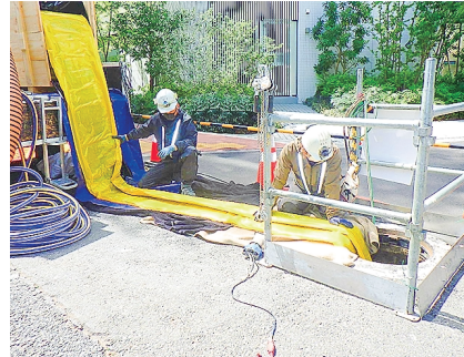
山口氏「何をやっているのかわからない時は工事現場にいいイメージがありませんでしたが、知ると下水道の仕事は素晴らしいと思うようになりました」(管更生の現場、写真提供:東亜グラウト工業)
